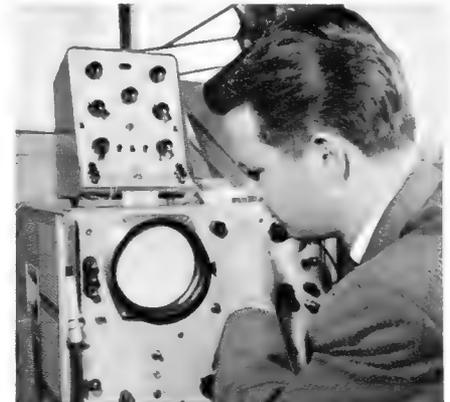
Der *Elliot-Transistor-Kennliniensreiber*, im Bild oben, arbeitet in Verbindung mit dem darunter befindlichen normalen Labor-Oszillografen
